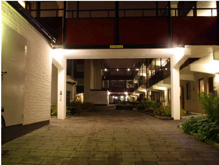
Exempel på god belysning där ljuset från armaturerna sitter på båda sidor av gångvägen vilket ger ett jämnt fördelat ljus över alla ytor.
