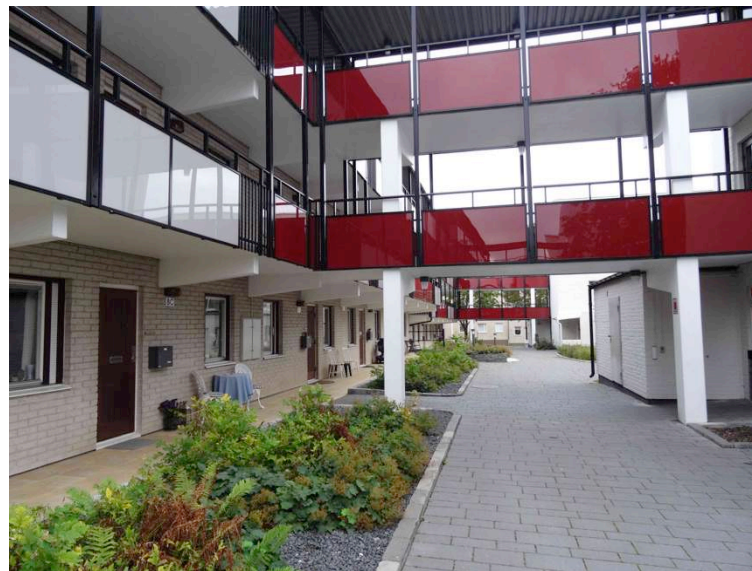
Exempel på markbeläggning som är fast, jämn och väl markerad mot angränsande ytor vilket ger såväl ökad framkomlighet som hög orienterbarhet.
