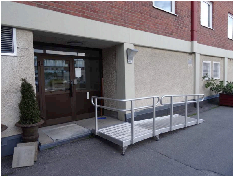
Exempel på en tillbyggd ramp med ett vilplan som avhjälper den ursprungliga entrétrappan vilket gör entréplanet nåbart med rullstol och rollator.
